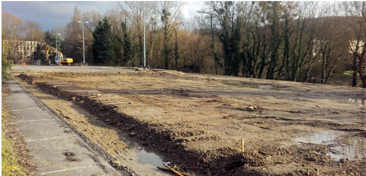
LES PREMIERS TERRASSEMENTS
